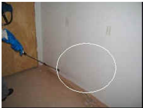
Figura 3. Aspectos da borrifação. Detalhe para o leque cobrindo a faixa de 75cm.
