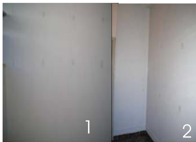
Figura 1. Dependências do Serviço Regional de Araçatuba (SP). Aspectos da parede preparada com acabamento em látex tipo PVA (1) e semibrilho (2).
