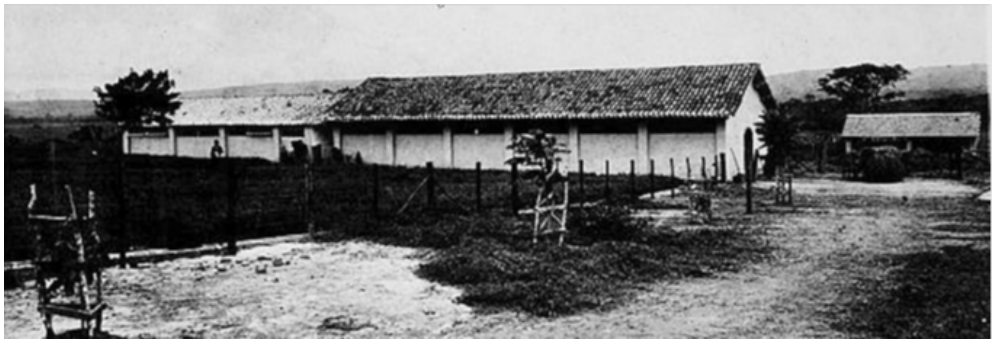
Figura 7. Antiga cocheira da Fazenda Butantan, s/d. Foto: autor desconhecido. Foi a instalação original da Fazenda Butantan onde Vital Brasil improvisou laboratório de produção de soros. A imagem serviu de base para a réplica erguida em 1981, sob a direção do arquiteto Osmar Mammini. Acervo Instituto Butantan/Núcleo de Documentação.
