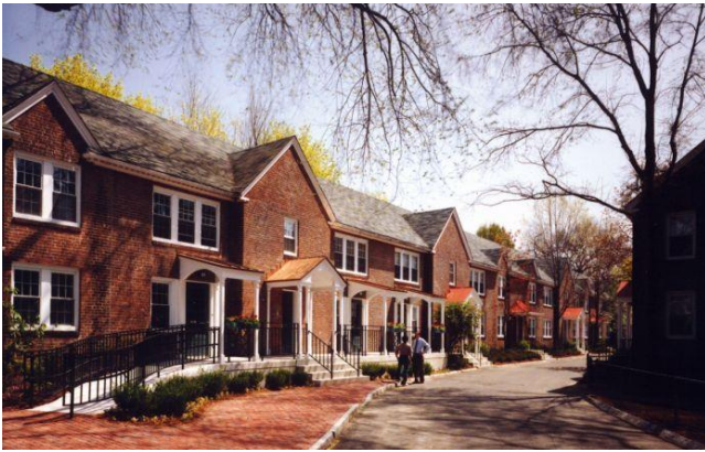
Imagem 18. Shaler Lane Housing, Universidade - Cambridge, MA. Harvard University Housing. Conjunto construído em 1920. Fonte: http://huhousing.harvard.edu/
