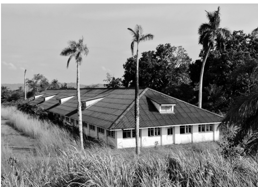
Figura 7 – Hospital de Fordlândia, um dos mais modernos e bem equipados da região Norte na década de 1930, com dois amplos pavilhões de enfermarias, centro cirúrgico, sala de parto, consultório dentário e sala de RX (data: década de 1980).
