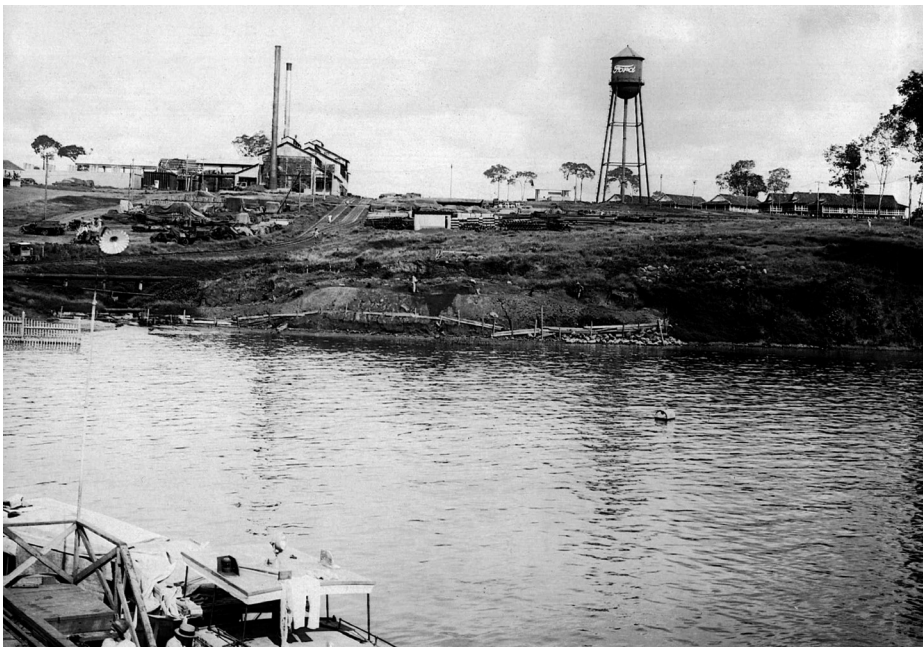
Figura 2 – Aqueduto para captação de água e caixa d'água de Fordlândia, instalada em local de fácil visualização aos que navegavam pelo Rio Tapajós (data: década de 1930).
