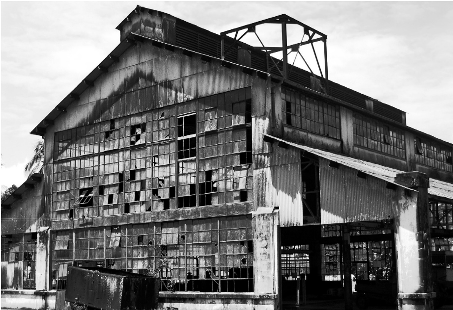
Figura 12 – Vista externa do barracão central que abrigava escritório, almoxarifado e seção de eletricidade (data: década de 1980).
