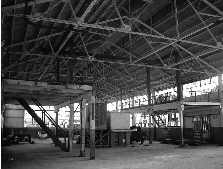
Figura 13 – Vista interna do barracão central de Fordlândia (data: década de 1980).
