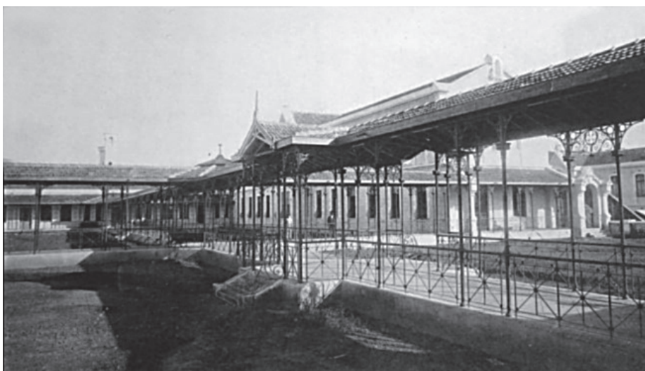
Figuras 1 e 2: Vistas do antigo Asilo de Alienados do Juquery (externa e interna). Imagens retiradas do catálogo do arquiteto Ramos de Azevedo. (Fonte: Biblioteca Central da POLI-USP).
