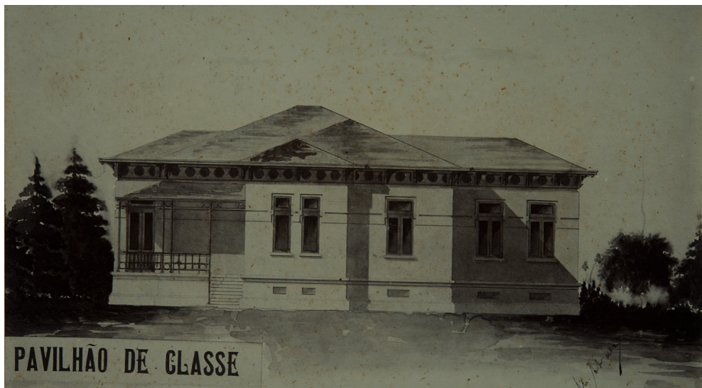
Figura 9. I-IB_ICO_009389 – Pavilhão de Classe, elevação, s/d. Fonte: Autor desconhecido. Acervo Instituto Butantan/Núcleo de Documentação.
