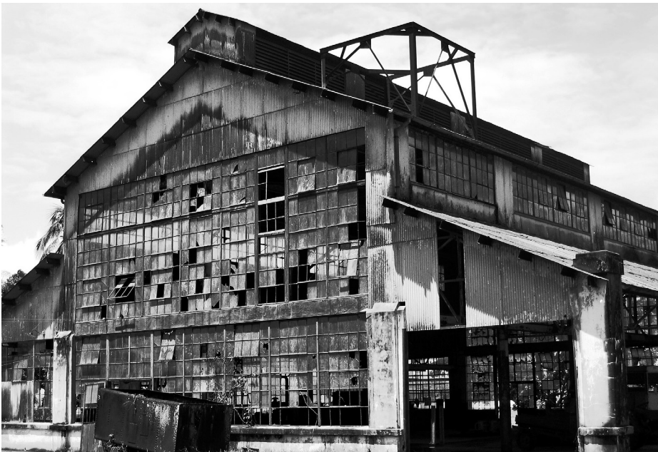
Figura 12 – Vista externa do barracão central que abrigava escritório, almoxarifado e seção de eletricidade (data: década de 1980).
